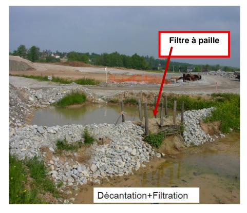
Figure 63 : Exemple de bassin de décantation provisoire avec filtre à paille Source : http://www.setra.equipement.gouv.fr/IMG/pdf/9-\_Guide\_Chantiers\_routiers.pdf
