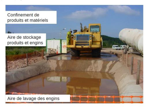
Figure 61 : Exemple d'une aire de chantier avec une fosse de nettoyage Source : http://www.setra.equipement.gouv.fr/IMG/pdf/9-\_Guide\_Chantiers\_routiers.pdf
